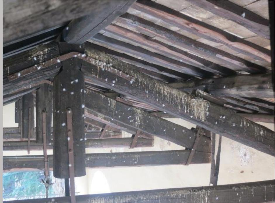
Grede su prvo detaljno očišćene. Posude Bird Free vatrenog gela su nakon toga postavljene sa gornje strane kose grede sa razmakom od 200mm (leva slika), i na ravne grede ispod sa razmakom od 250mm (desna slika)
